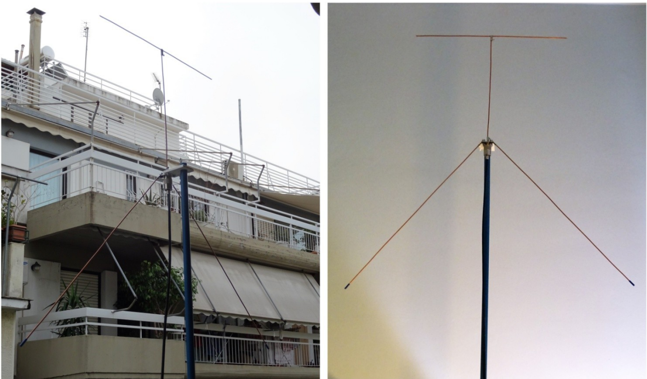
Εικόνα 3 - Η κεραία σε εξωτερική και εσωτερική εγκατάσταση
